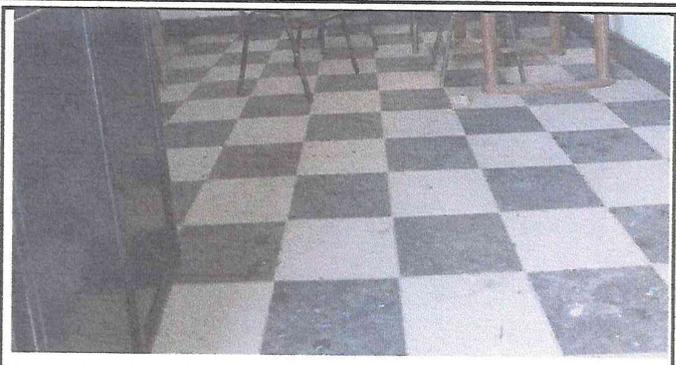
Foto 2: Área de la sustitución de piso de granito por cerámico finalizado
